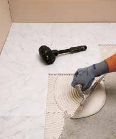
Colocación de mármol blanco con Keraquick S1 blanco
